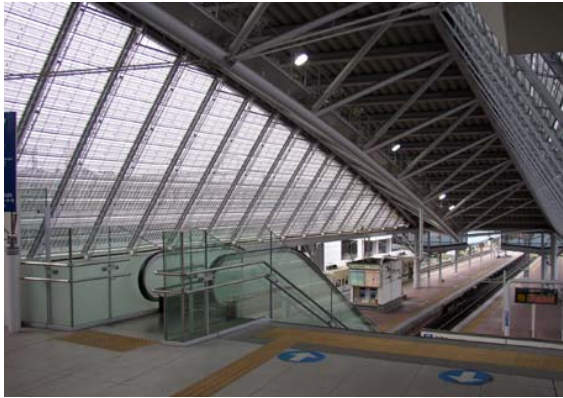
Odakyu Odawara-Line Odawara Station (Kanagawa pref.)
