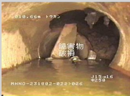
Collapsed Conduit
